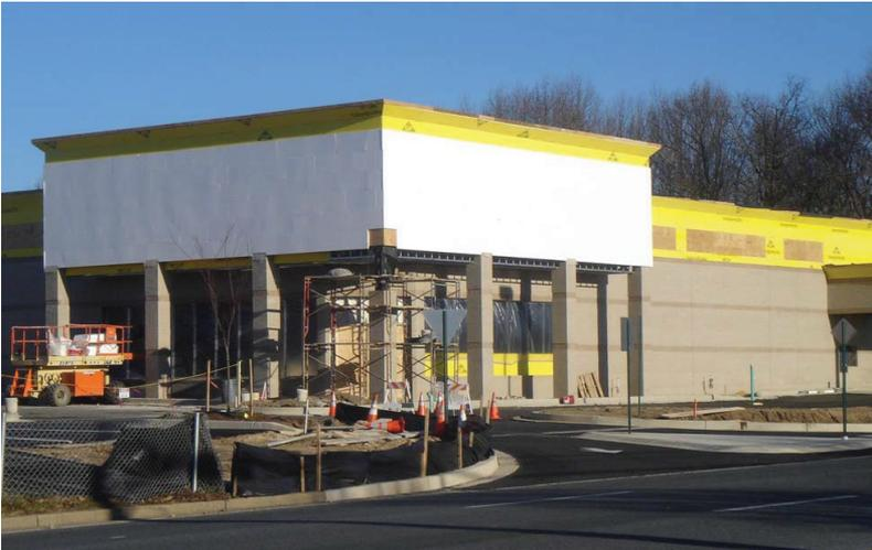
El aislamiento exterior debe estar protegido por un sistema de revestimiento. Algunos ejemplos son EIFS, estuco, chapa de ladrillo, revestimiento del solapado y paneles de metal o cemento.
