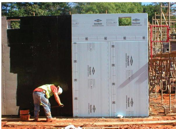
Instalación de un revestimiento impermeable instalado bajo un aislamiento continuo en una pared de hormigón.
