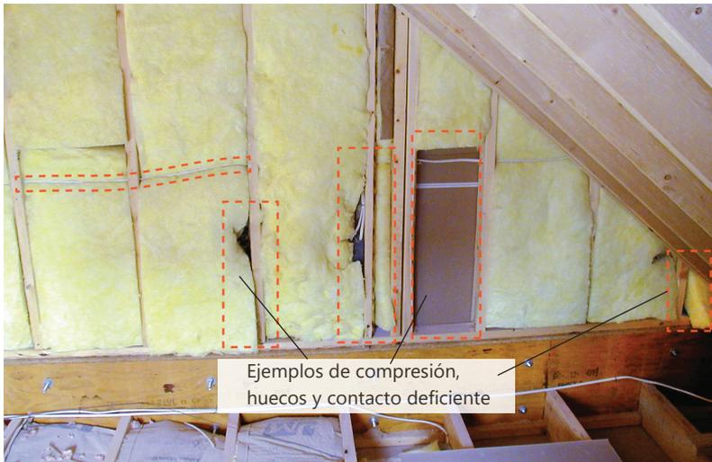
**Instalación inaceptable:** El valor R del aislamiento se reduce por los huecos, los espacios vacíos, la compresión, la humedad y la falta de contacto con la barrera de aire en todos los lados.
