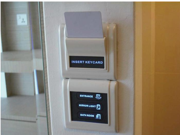
Al retirar la tarjeta de acceso al salir el ocupante, la energía de iluminación se interrumpe automáticamente para todas las luces interiores.
