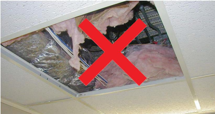
El aislamiento de la envoltura no se puede instalar en la parte superior de los paneles del techo suspendido. Se pueden aislar los techos caídos/suspendidos para evitar el ruido, pero ese aislamiento no puede contarse como parte del valor R de aislamiento del techo.
