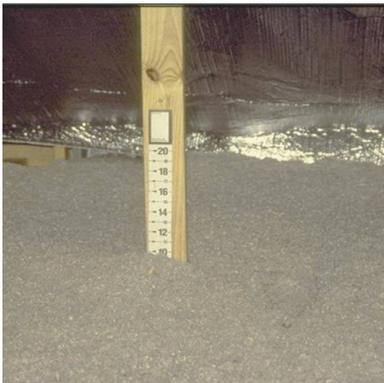
La regla muestra la profundidad del aislamiento soplado instalado. El aislamiento de fibra de vidrio soplado típico tiene un valor R de alrededor de R-3 por pulgada; de 12 a 14 pulgadas de aislamiento soplado es típico para lograr R-38.
