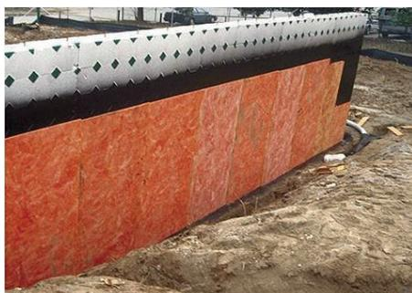
El encofrado aislante de hormigón excede el código al proporcionar un aislamiento continuo en el interior y exterior de los cimientos.
