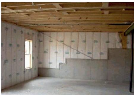
INCORRECTO (CZ3): Aislamiento no en la parte del encofrado de hormigón de la pared del sótano.
