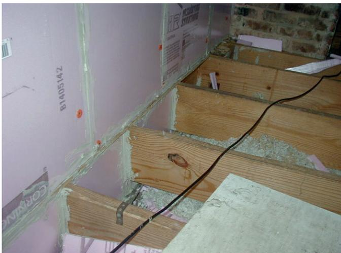
CORRECTO: cavidad de viga bloqueada/barrera de aire sellada del lado del ático
