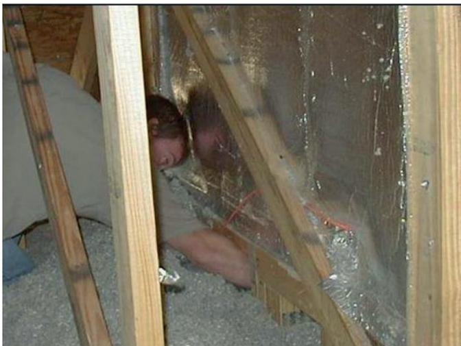
INCORRECTO: cavidad de viga desbloqueada. El inspector está llegando a través de la cavidad de la viga desbloqueada, revelando una vía significativa para el aire no acondicionado del ático dentro de la envoltura del edificio.
