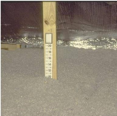
La regla muestra la profundidad del aislamiento soplado instalado. El típico aislamiento soplado tiene un valor R de alrededor de R-3.2 por pulgada. 12 a 14 pulgadas de aislamiento soplado es típico para lograr R-38.
